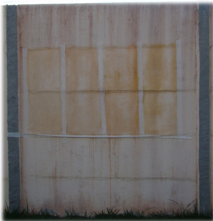
Lavagem dos painéis com solução sanitizante
