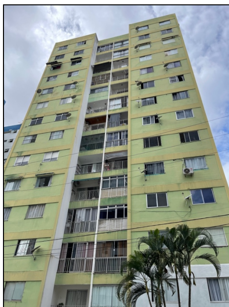
Imagem 02 – Fachada principal do Condomínio Edf. Iris
