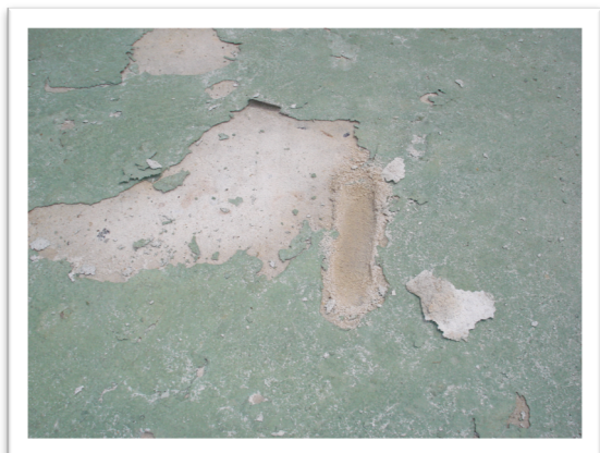
Figura 01: substrato excessivamente fraco.
